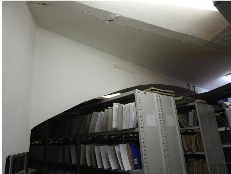
Slika 5: prikaz stropne konstrukcije v predelu kleti ob Raičevi ulici
