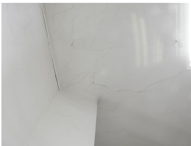
Slika 25: prikaz razpok v ometu stropa nad vrati v sanitarije
