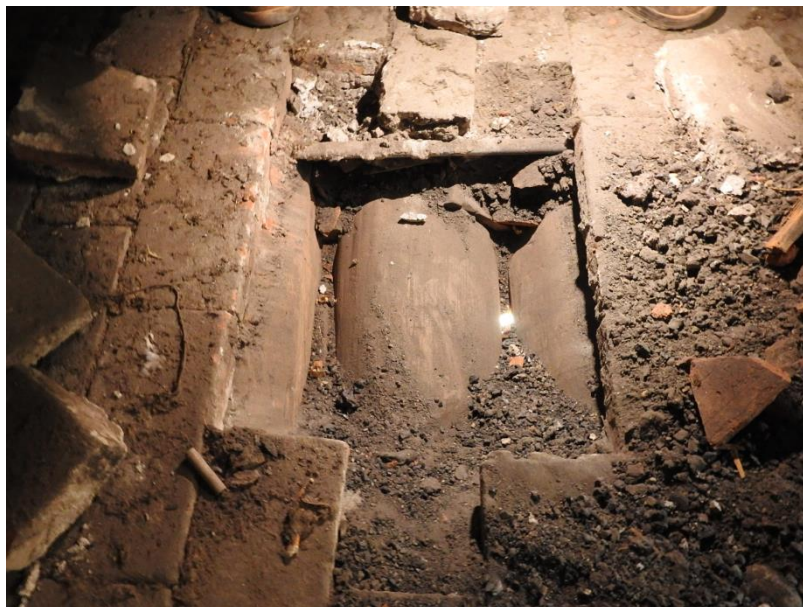
Slika 15: prikaz stropne konstrukcije v predelu sonde S4
