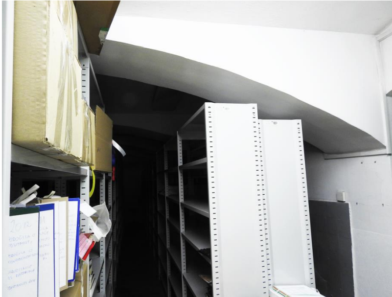
Slika 5.1: prikaz stropne konstrukcije v predelu kleti ob Slomškovi ulici
