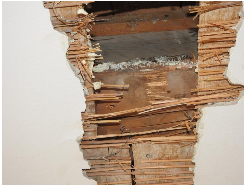
Slika 11: prikaz stropne konstrukcije po izvedeni sondi S3
