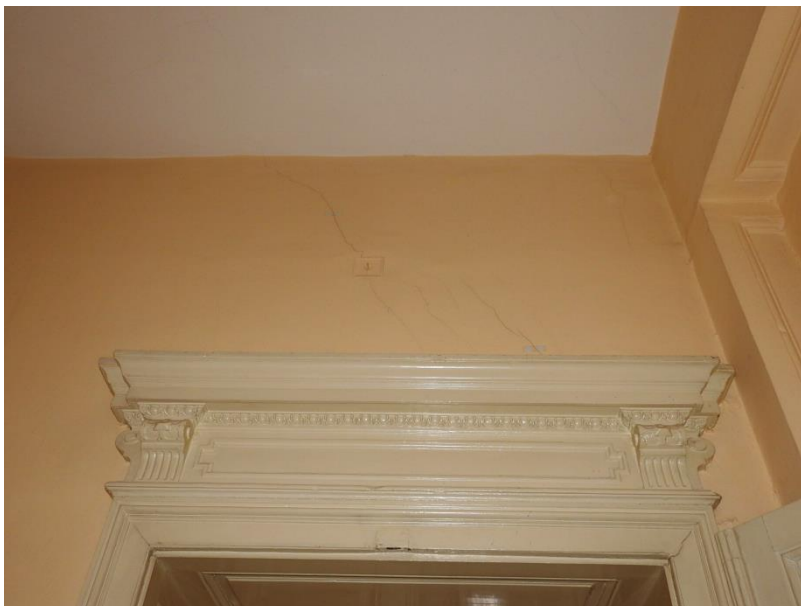
Slika 20: prikaz razpoke v prekladi nad vrati v sobo št. 10
