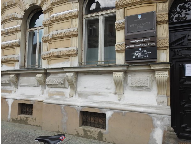
Slika 27: prikaz stanja dela fasade levo od vhodnih vrat
