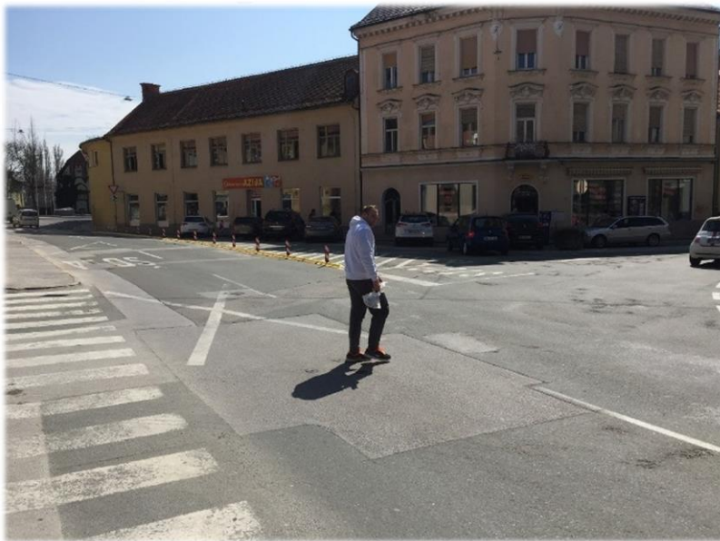
Slika 3: Pogled na križišče iz zahodne smeri
