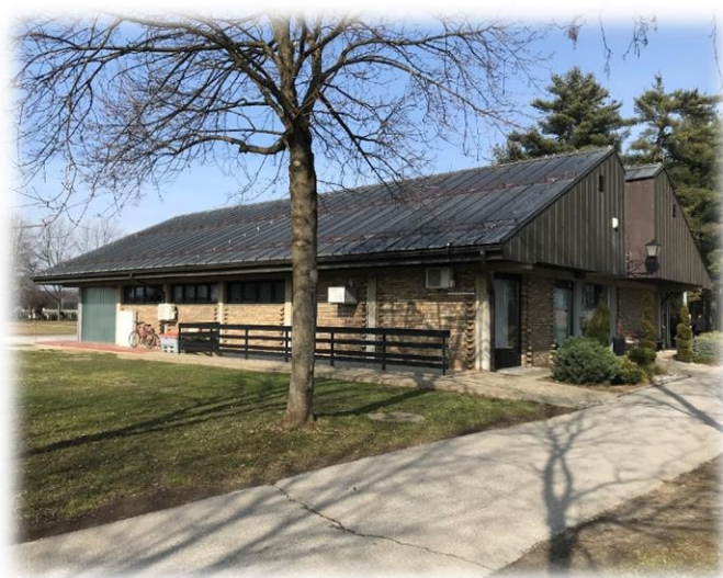
Slika 1: Obstoječe stanje vežice
