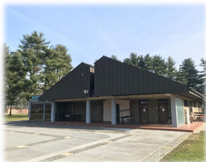
Slika 2: Obstoječe stanje vežice
