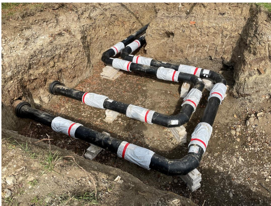
Slika 4: Izgradnja vročevoda po Osojnikovi cesti
