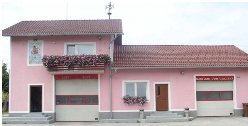
Slika 42: Prostovoljno gasilsko društvo Grajena.
