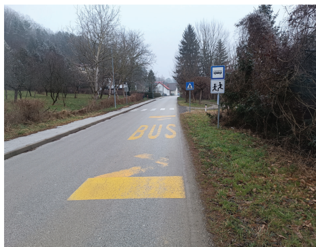
Slika 28: Primer obstoječega avtobusnega postajališča na vozišču v območju četrtne skupnosti Panorama (zaselek Orešje), ki je brez pripadajoče opreme.
