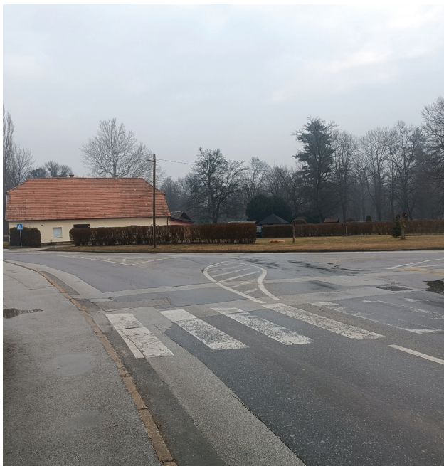
Slika 30: Za križišče Zagrebške ceste in Selske ceste se načrtuje izgradnja krožnega križišča.
